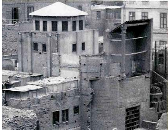
سطح بيت محب الدين بالقاهرة و المبني في القرن الخامس عشر حيث يظهر بوضوح الملفف و الشخصيشة.
